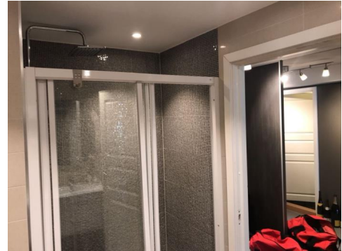
Bildet viser dør i våtsonen.
